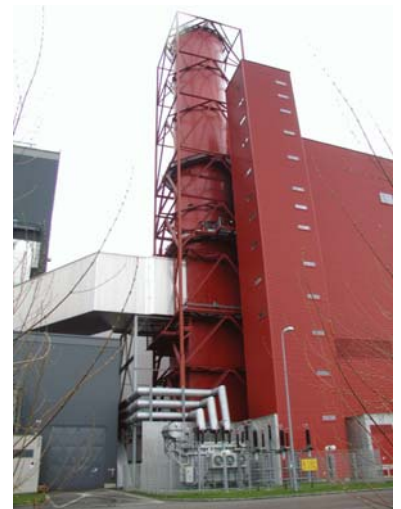
Abb. 2: Hilfskamin mit Flügelklappe
