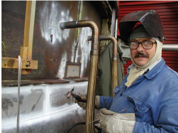
Abb. 23: Revisionsarbeiten an der Außenseite des Hilfskamins
