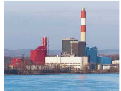
Abb. 1: Ansicht von der Donau auf das kalorische Kraftwerk „Theiß“ mit Hilfskamin
