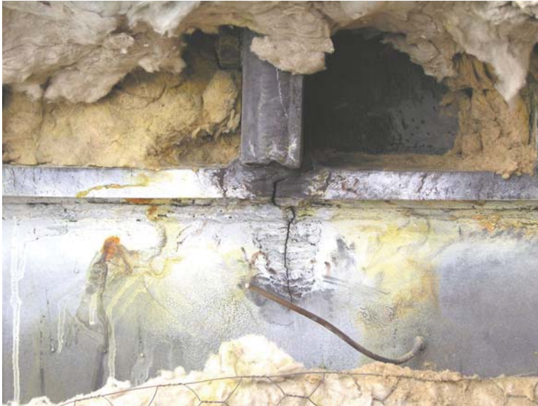
Abb. 5: Außenansicht des Risses im Flansch (Isoliermaterial entfernt)
