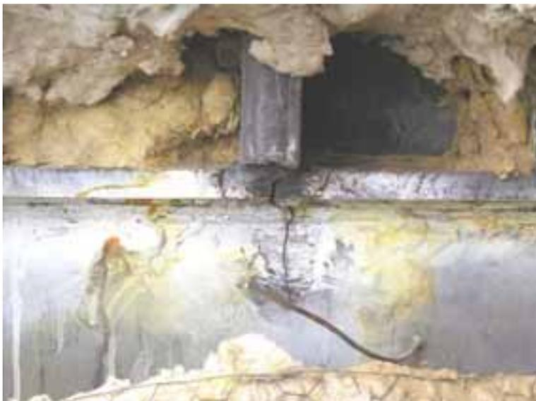
Abb. 5: Außenansicht des Risses im Flansch (Isoliermaterial entfernt)
