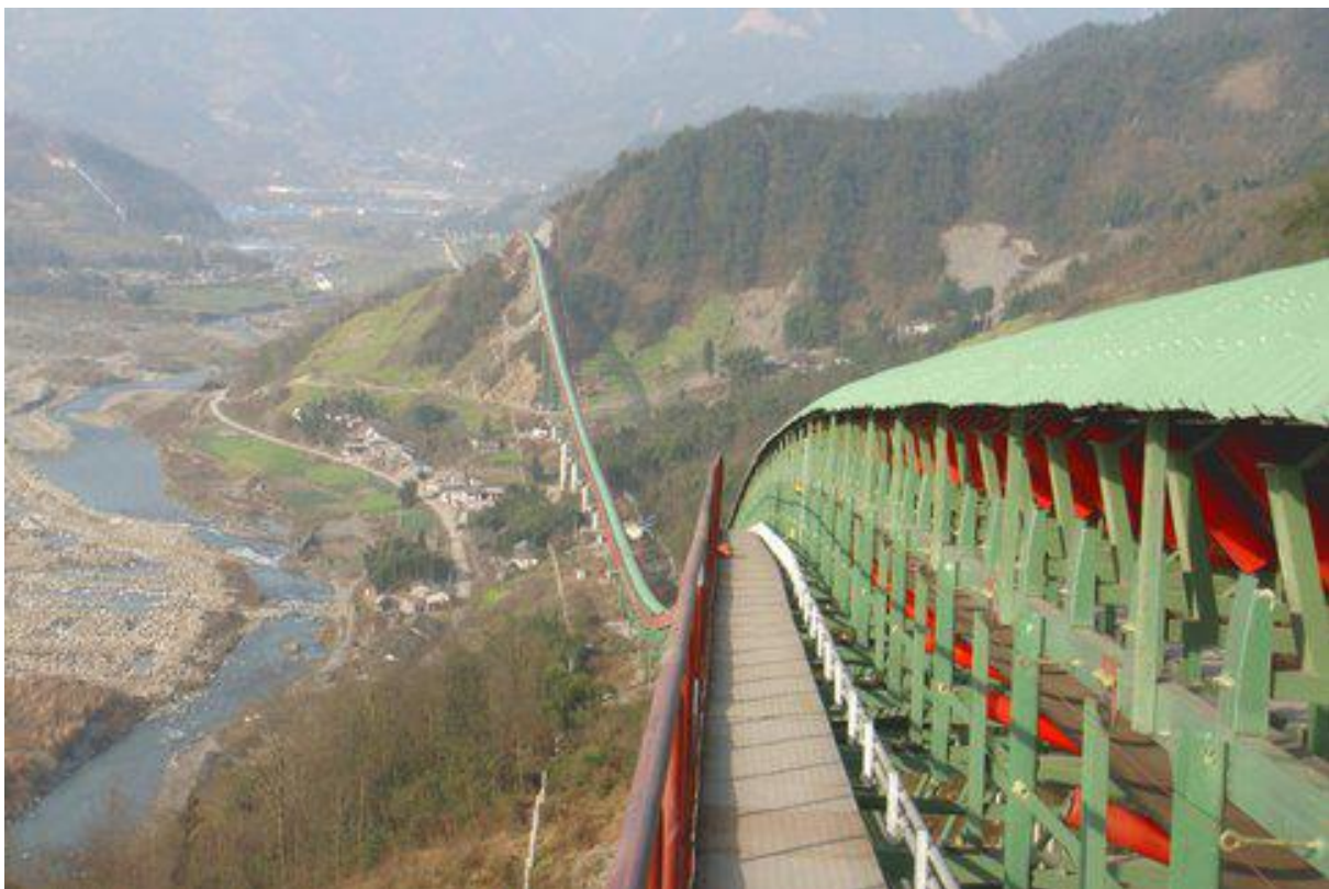
Abbildung 1: Gurtförderanlage in Sichuan, China Ausgabe 39
